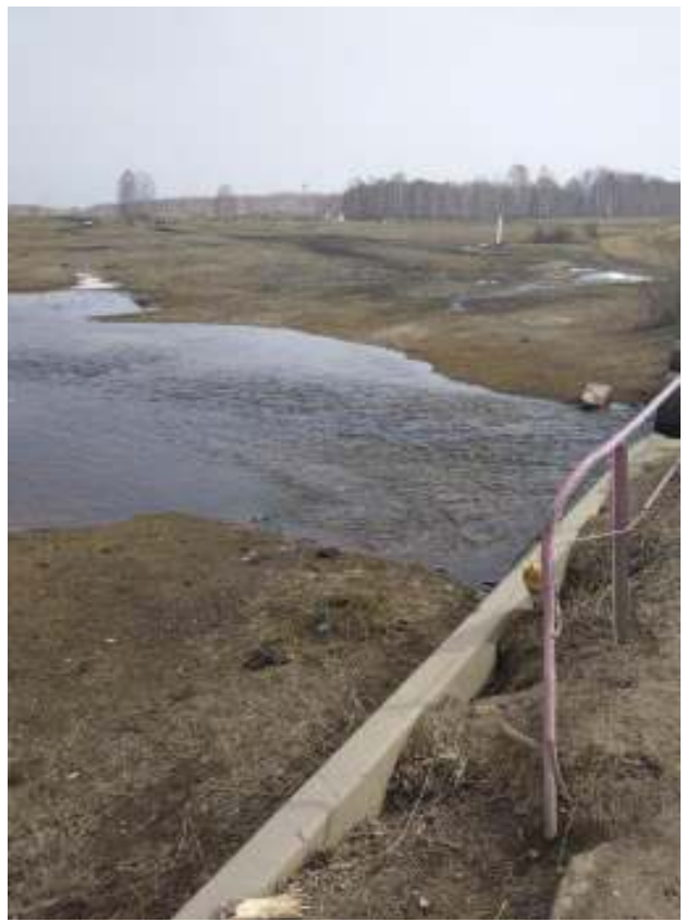
Рис.4 Река ниже существующего моста
