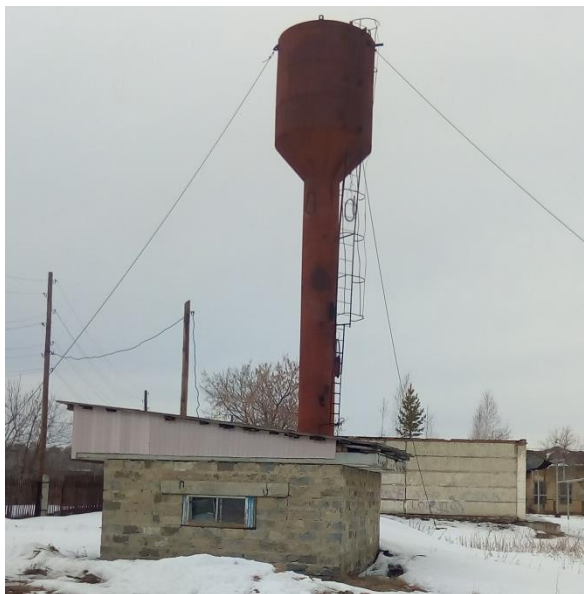
Надкаптажное помещение скважины и водонапорная башня в зоне жилой застройки.
