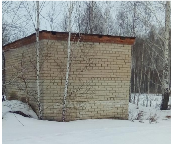
Надкаптажное помещение скважины.
