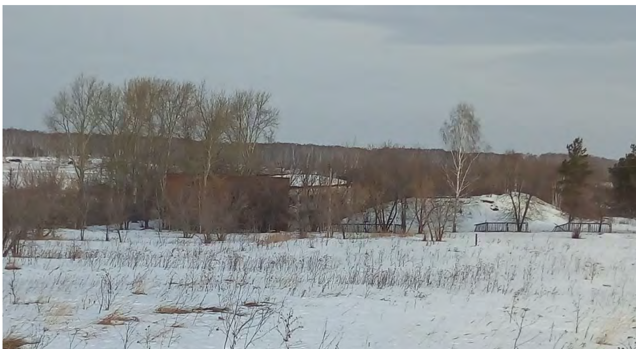
Здания и сооружения КОС.
